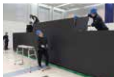
スムーズな設置作業
